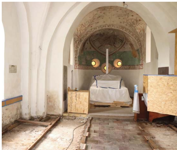
I efteråret 2020 pågår der er en stor indendørs restaurering af Nr. Jernløse Kirke. Kirken skal kalkes indvendigt, og der installeres et ny varmeanlæg. Endvidere bliver våbenhuset restaureret og indrettet på ny. Vi glæder os til at se resultatet, som forventes færdigt til jul.
